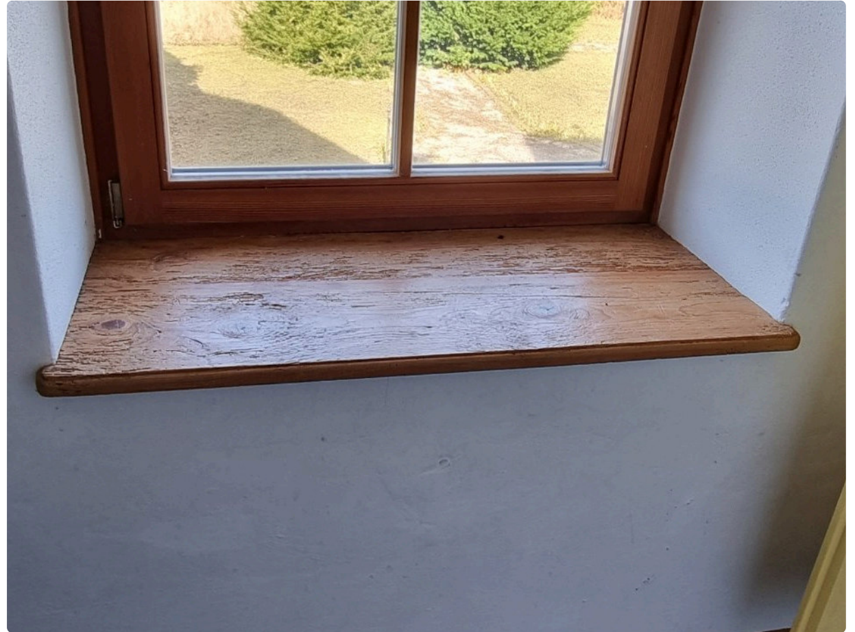
Holzfensterbänke aus Altholz ziehen sich durch das ganze Haus
